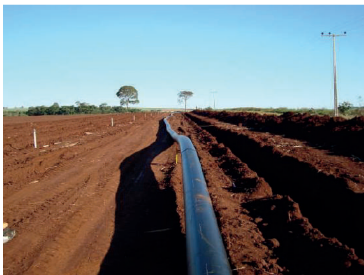
Figura 13 - Instalação de tubos em PEAD
