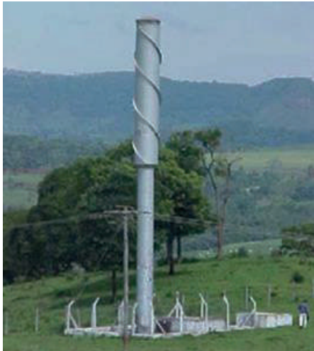
Figura 29 - Tanque Alimentador Unidirecional - TAU
