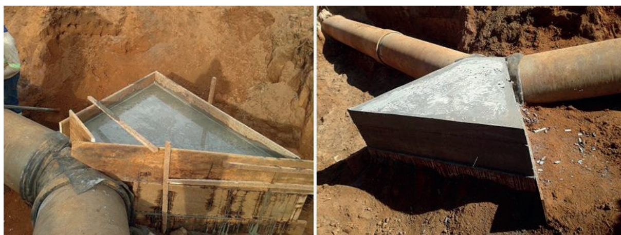
Figura 77 - Bloco de Ancoragem em Curva
