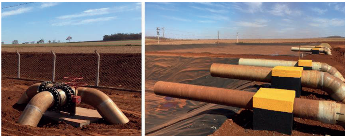
Figura 78 - Ancoramento Metálico / Ancoramento em Concreto
