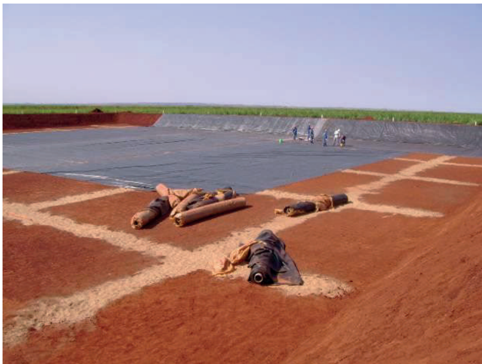
Figura 49 - Construção de Reservatório Revestido de PEAD
