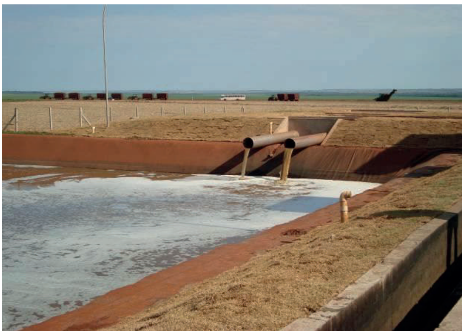
Figura 50 - Reservatório Revestido com manta PEAD
