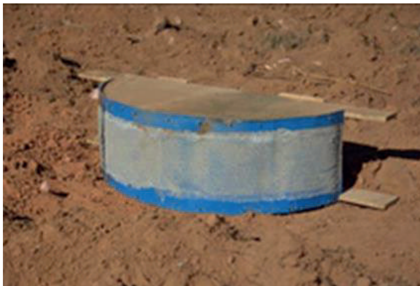
Figura 81 – Exemplo de molde para construção do berço
