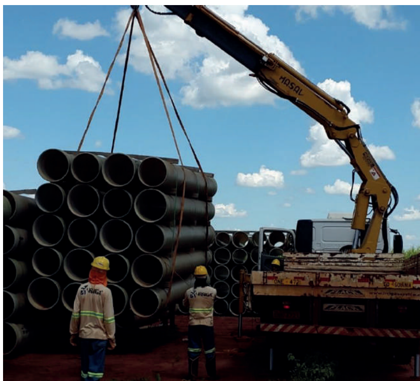
Figura 58 - Descarregamento de Pallet
