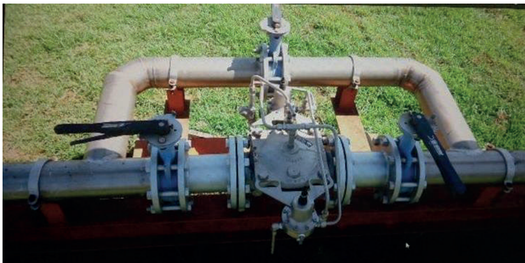
Figura 54 - Exemplo de instalação de Válvula Antecipadora de Onda - para vinhaça e/ou águas residuárias
