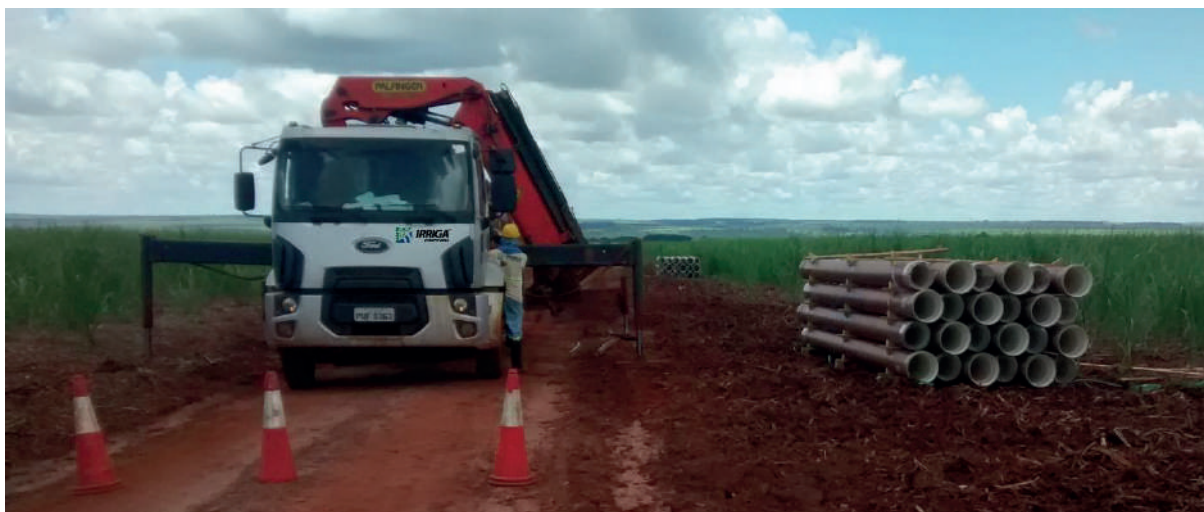
Figura 64 - Distribuição da tubulação em campo
