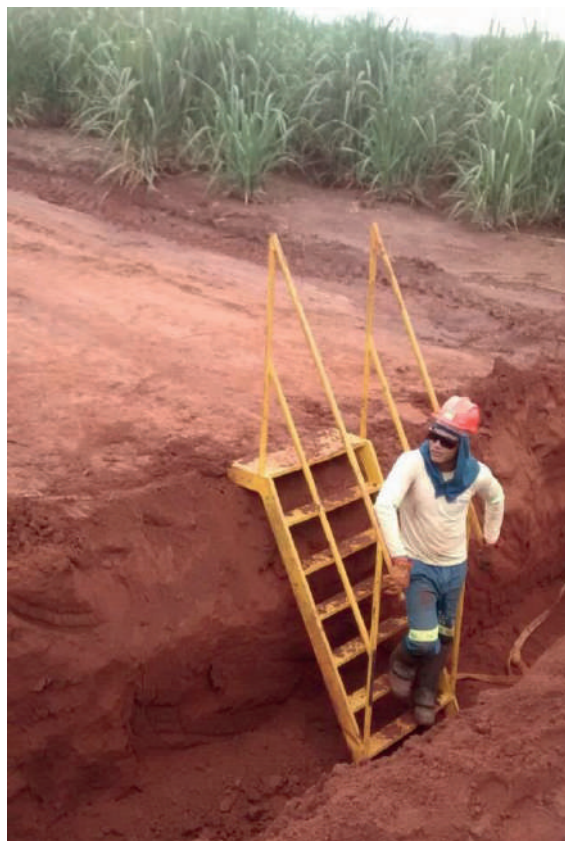
Figura 61 - Escada para acesso a vala
