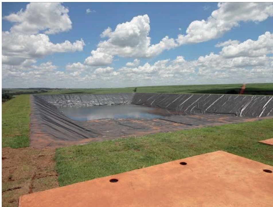
Figura 51 - Reservatório Revestido com manta PEAD
