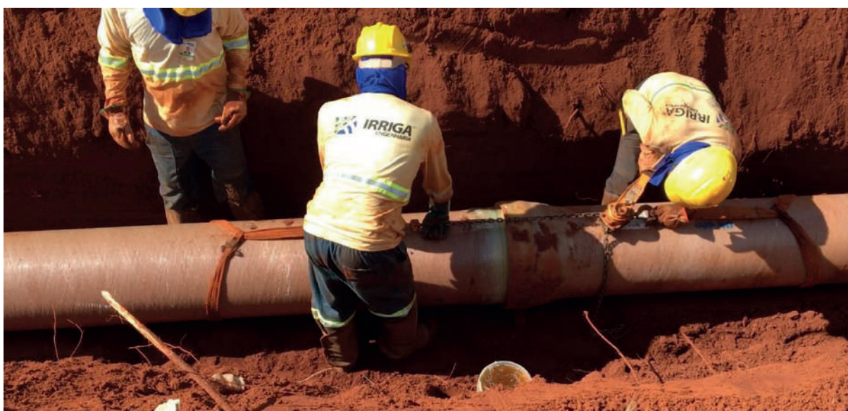
Figura 65 - Montagem da tubulação com catraca
