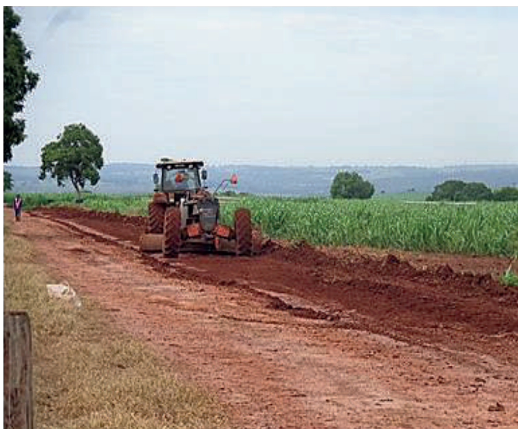
Figura 60 - Limpeza do traçado da adutora
