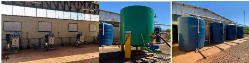
Figura 169 – “Fábrica” de fertilizantes em cada estação de bombeamento. (Fonte: NaanDanJain).
