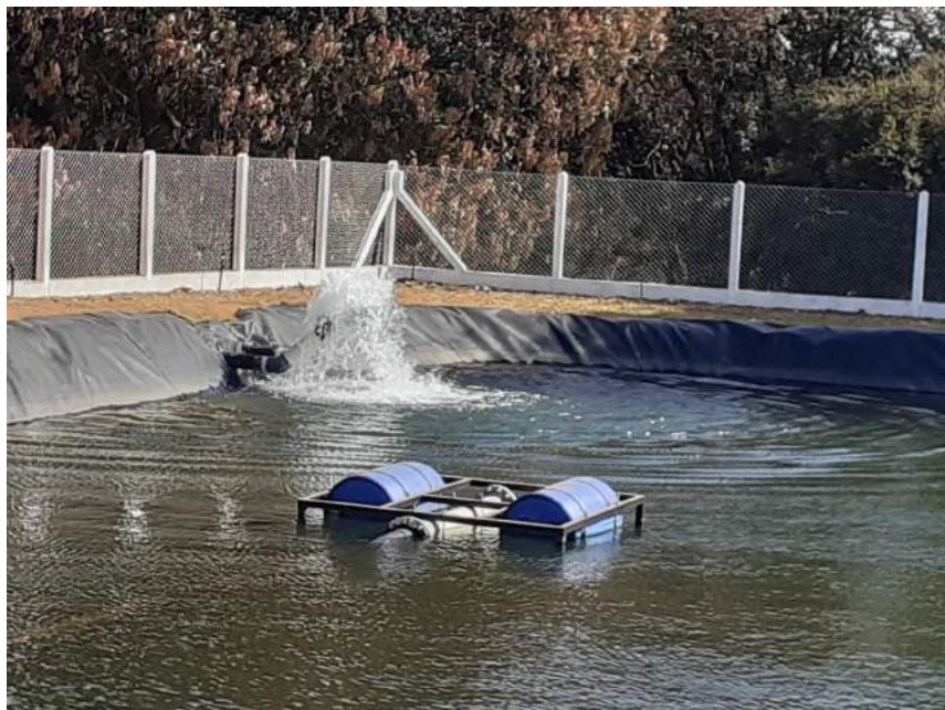
Figura 110 – Armazenamento impermeabilizado com geomembrana e cerca para segurança e proteção (Foto: Carlos Barth).
