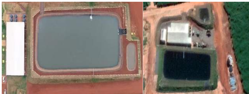
Figura 173 – Reservatório adicional para decantar a água da retro lavagem, Da Mata à direita e Usina localizada em Goiás à esquerda. (Fonte: NaanDanJain).
