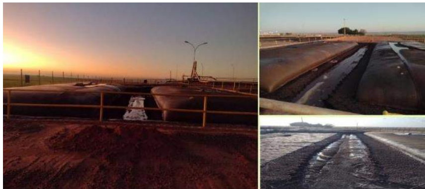
Figura 171 – Aplicação de vinhaça e água residuária no sistema de irrigação após passar por um filtro BAG. (Fonte: NaanDanJain).
