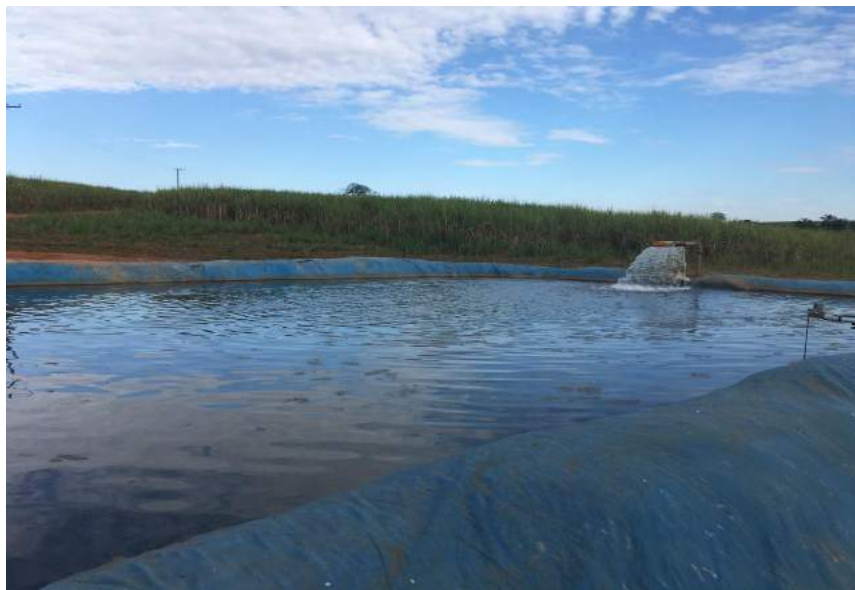
Figura 109 – Tanque de decantação (Foto: Daniel Pedroso).
