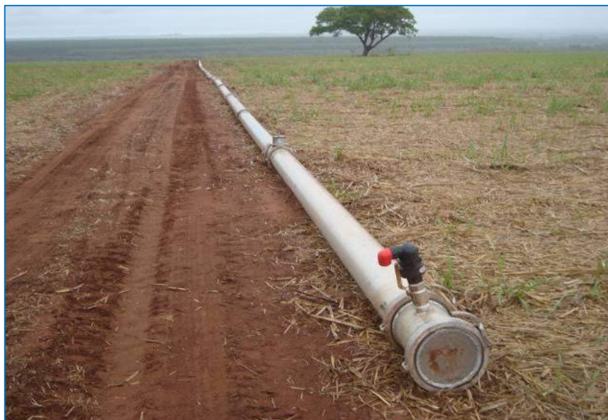
Figura 58 - Adutora móvel de Alumínio.
