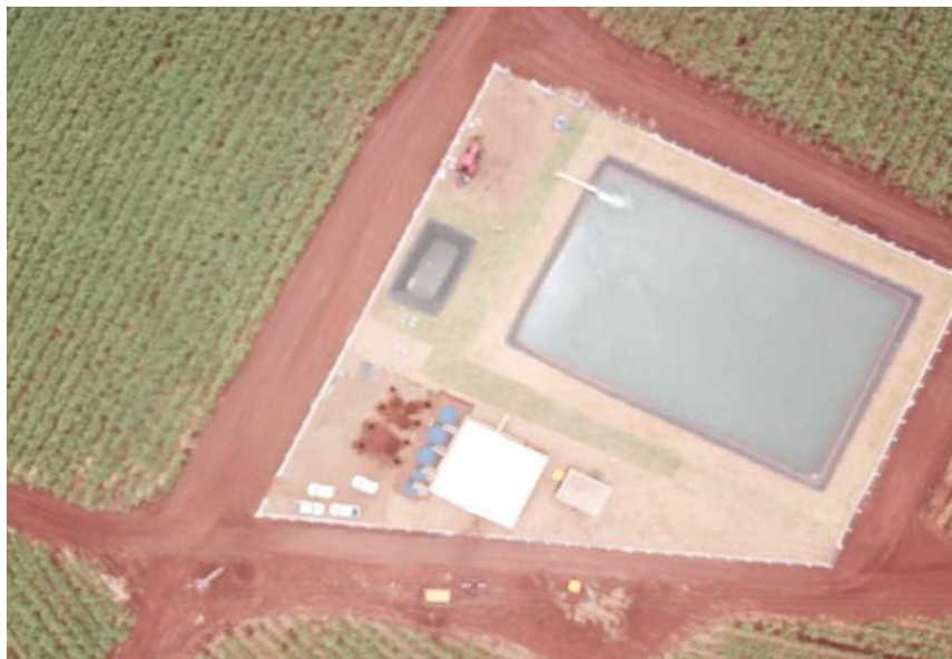
Figura 107 – Foto aérea em planta de uma estação de bombeamento.
