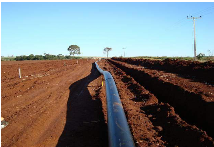
Figura 115 – Instalação de adutora no campo.
