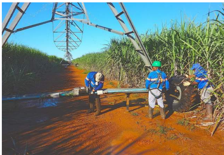
Figura 74 - Sistema pivô central rebocável sendo preparado para reboque.
