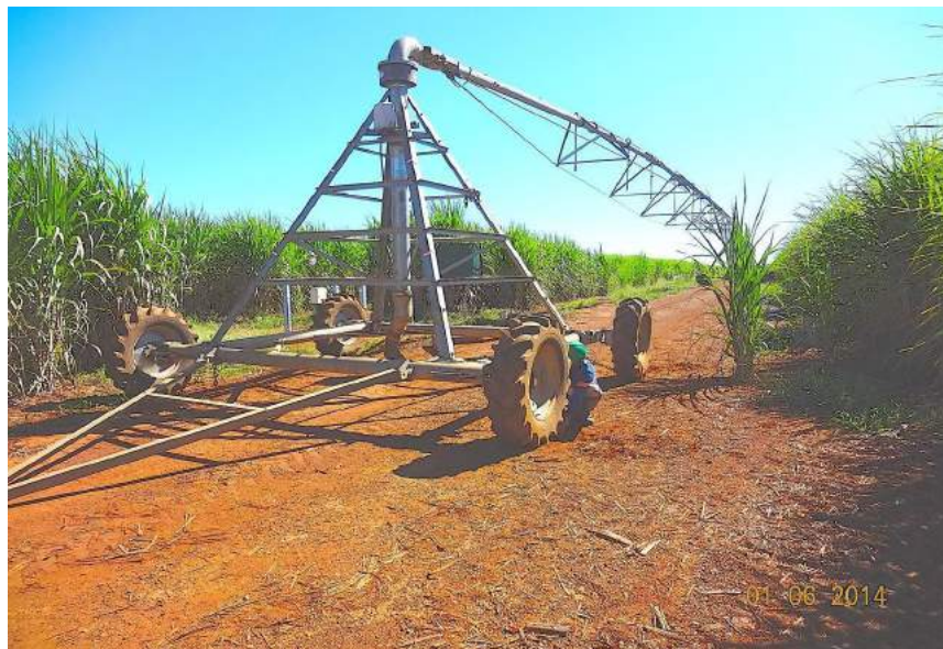
Figura 73 - Sistema pivô central rebocável sendo preparado para reboque.
