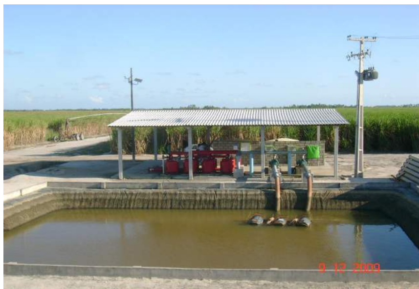
Figura 106 – Estação de bombeamento de um sistema de irrigação por gotejamento.
