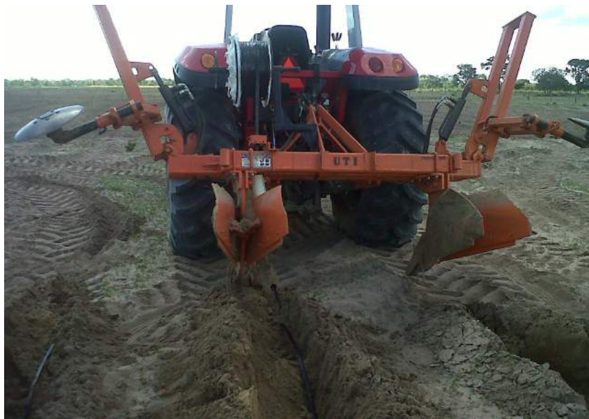
Figura 85 – Operação de enterrando de tubo de gotejo, Fazenda São Romão – NaanDanJain.
