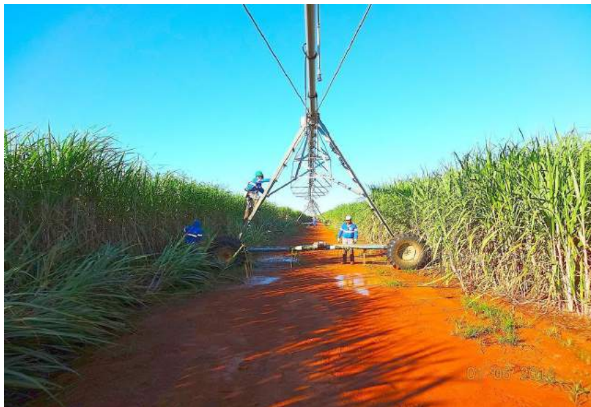
Figura 75 - Sistema pivô central rebocável sendo preparado para reboque.
